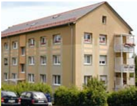
Alte Balkone wurden bei der Sanierung abgenommen und durch geräumigere Vorstellelemente ersetzt. Deutlich wird hier der Modernisierungssprung zwischen dem neuen und dem alten Zustand (Mitte).
