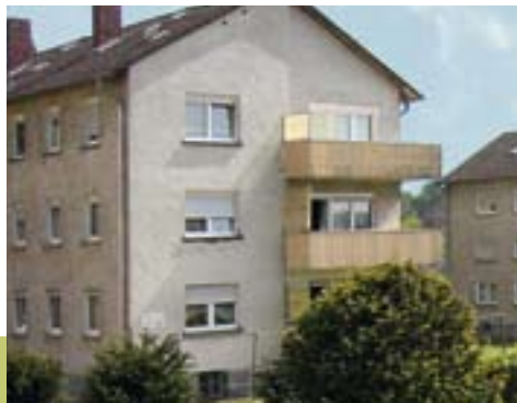
Alte Balkone wurden bei der Sanierung abgenommen und durch geräumigere Vorstellelemente ersetzt. Deutlich wird hier der Modernisierungssprung zwischen dem neuen und dem alten Zustand (Mitte).
